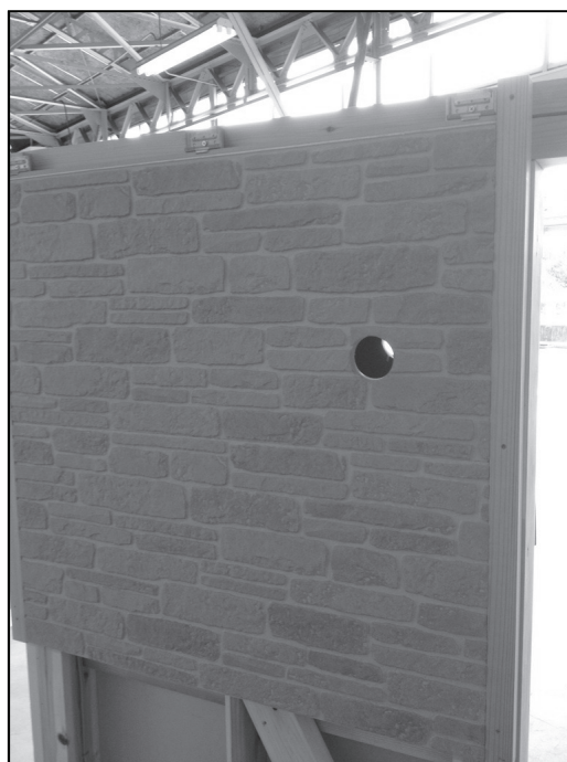
図6. 室外側穴あけ
