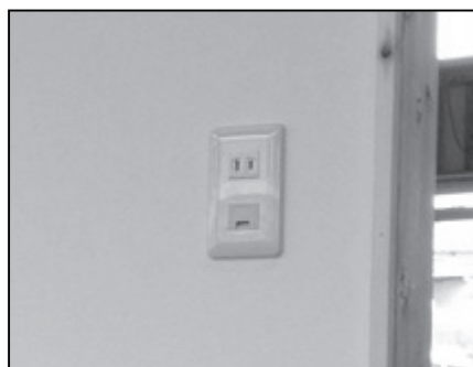
図7. エアコン用電源の増設
