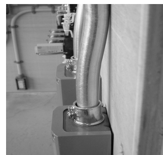
図2 金属管のS曲げ
