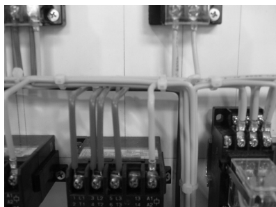
図3. 1 複数本重なる配線の処理
