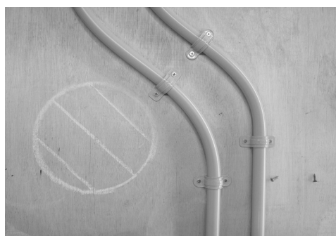
図5.2 障害物をかわす配管②
