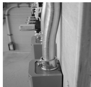
図2 金属管のS曲げ
