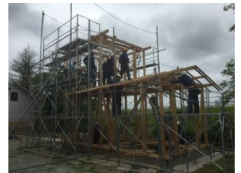
図 - 27 建方作業風景
