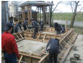
図 - 3 基礎工事の風景
