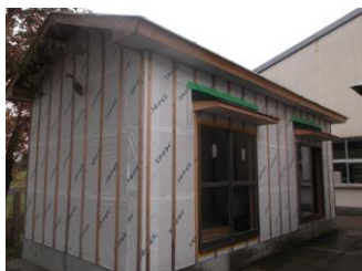
図 - 10 完成した模擬家屋外観
