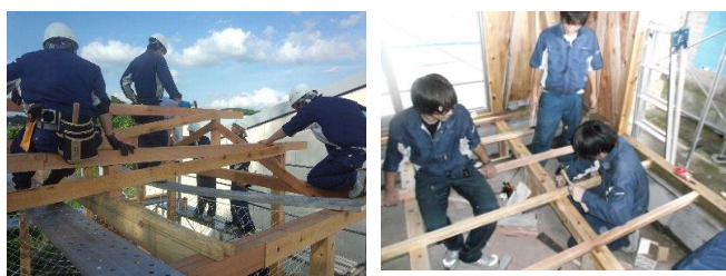
図 - 15 2階小屋組組立 図 - 16 一階床組作業
