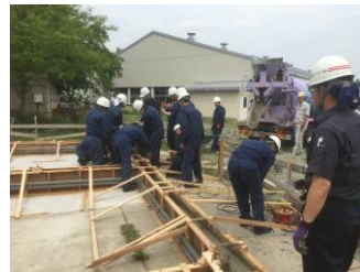
図 - 26 2016年度基礎工事の様子
