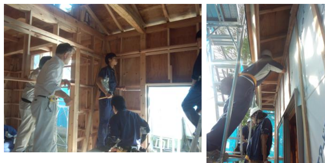
図 - 19 内部造作作業風景 図 - 20 軒天加工作業風景
