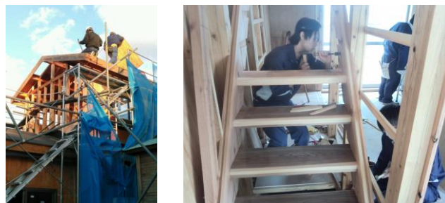
図 - 17 模擬家屋外観 図 - 18 内部造作作業風景
