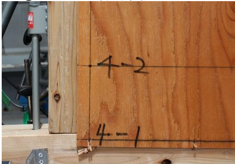
②釘のパンチング状況
