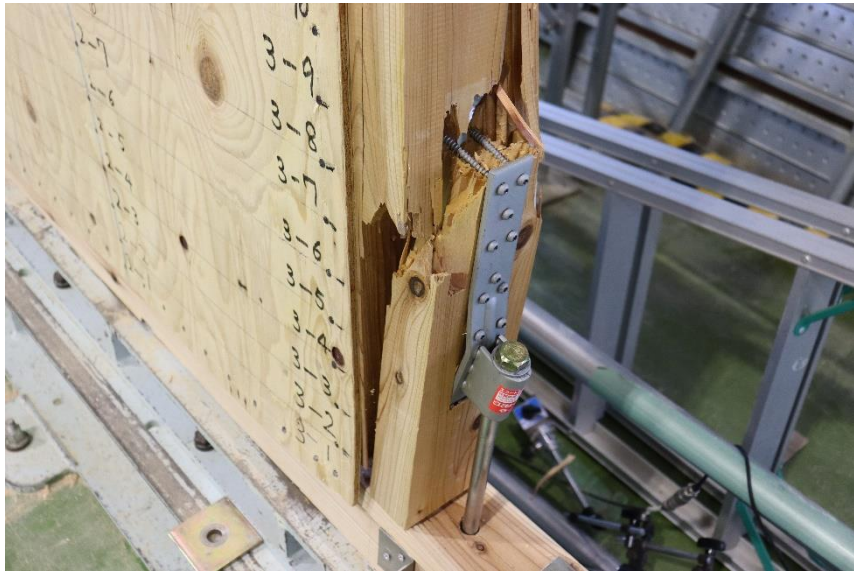
②引張力によるHD金物の割裂破壊の様子
