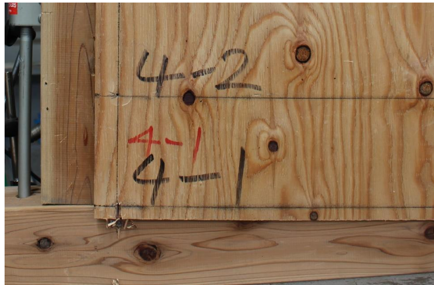
② 釘のパンチング状況
