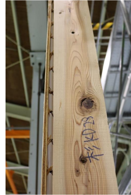
③引張力によるくぎのパンチングシアの様子
