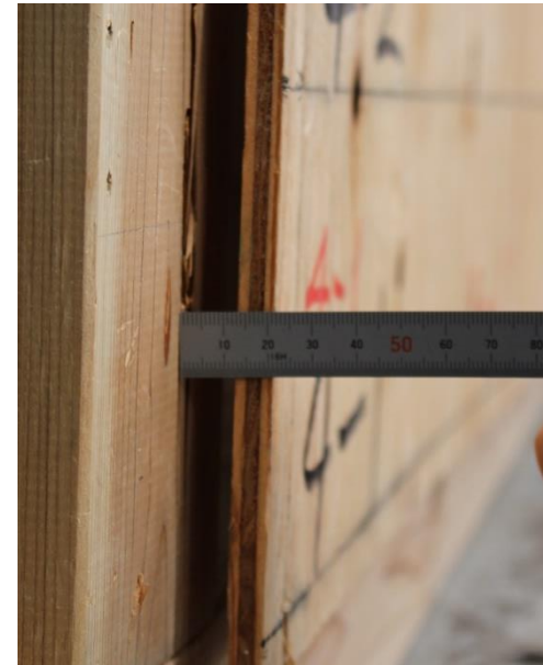
③ 面材の浮き(13mm)と釘のパンチング状況
