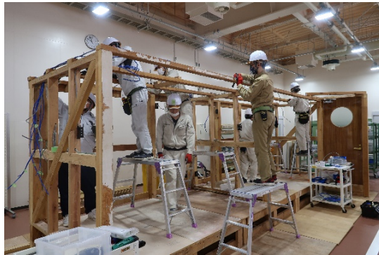
図6 電気配線工事
