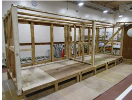
図3 模擬家屋の躯体
