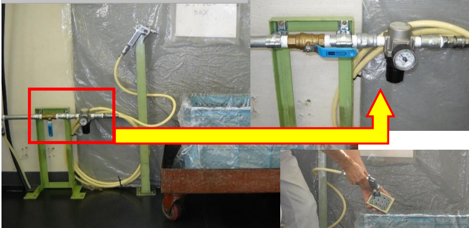
工場エアースourceにレギュレーター取り付け
