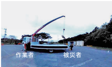
図8 つり荷落下 (全体視点)
