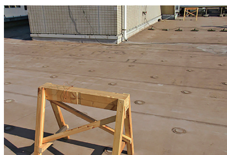
図12 アンテナの架設 (本校の屋上)
