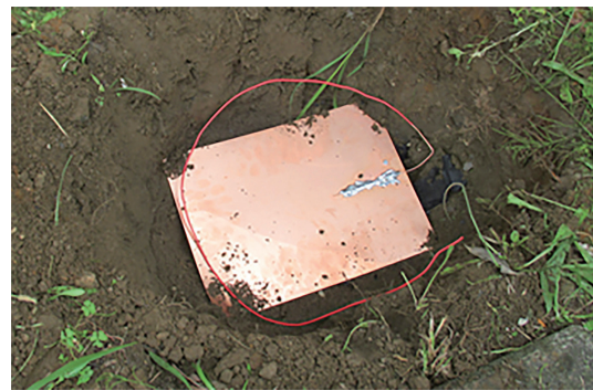
図13 接地板埋設のようす
