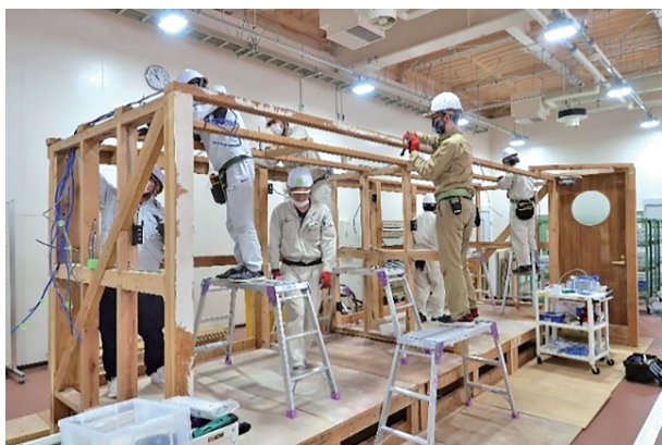
図6 電気配線工事
