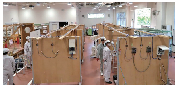
図2 電気配線の様子（以前）
