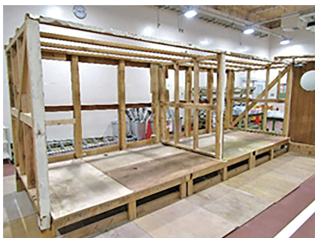
図3 模擬家屋の躯体
