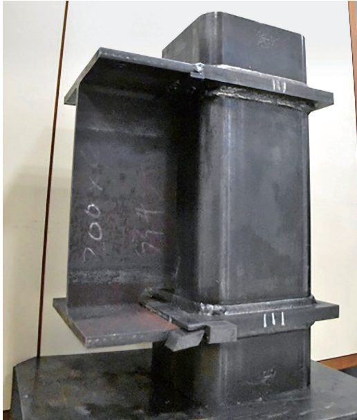
図1 欠陥（入り）鉄骨接合部
